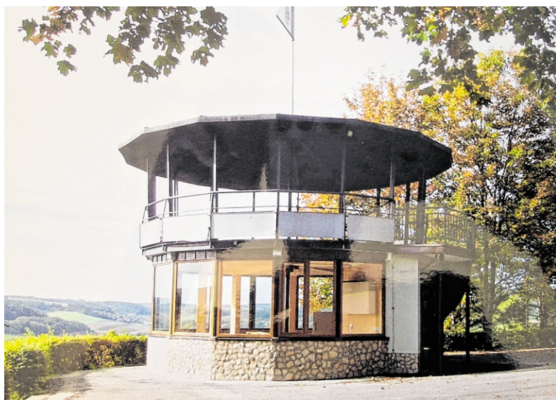
Der Pavillon in Schweigern erstrahlt nach umfangreicher Sanierung in neuem Glanz. Sein 60. Geburtstag wird mit einem Fest gefeiert.
