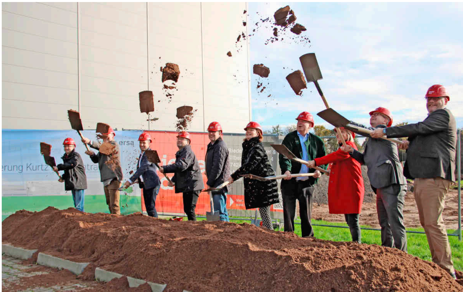
Spatenstich für den Erweiterungsbau der Kurtz Ersä Logistik im Kreuzwertheimer Ortsteil Wiebelbach.
