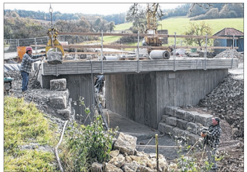
Wackersteine setzen die Arbeiter an der Hohenklingenbrücke bei Haagen an ihren Platz. Das Bauwerk soll Mitte November fertig sein.
