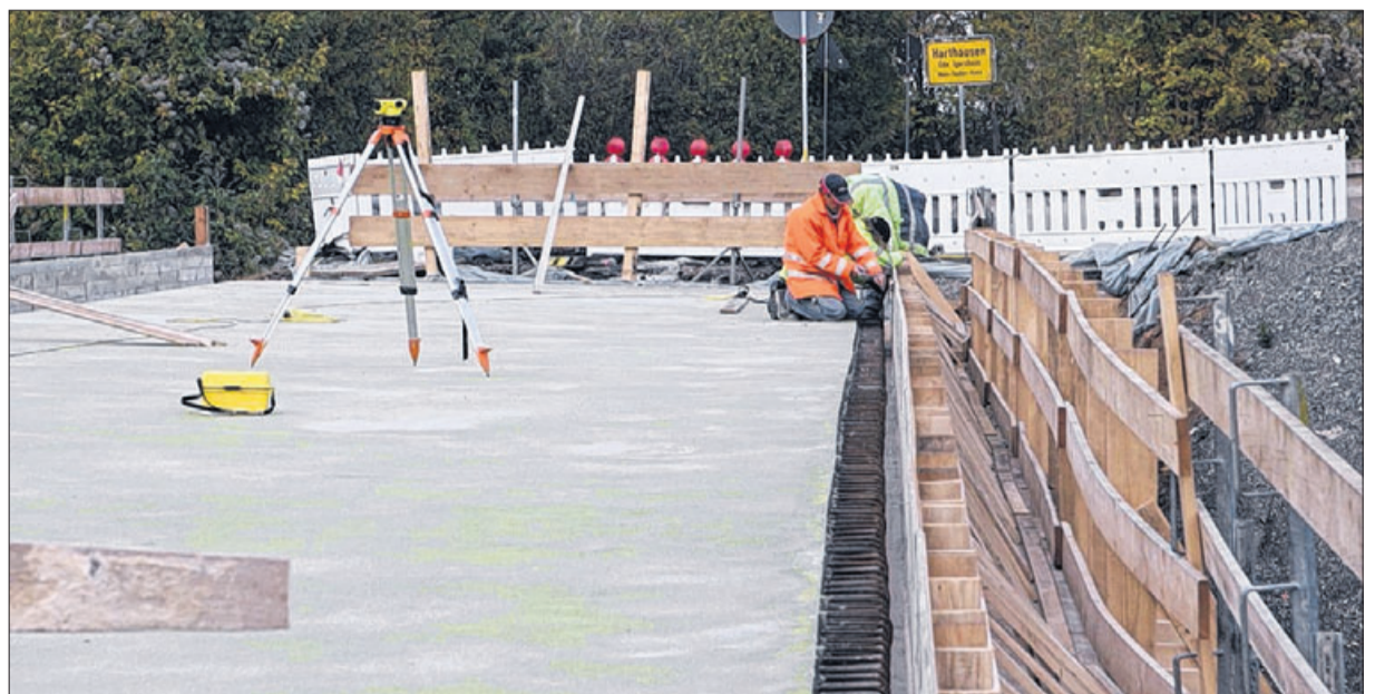
Der im Juli begonnene Neubau der Feldwegbrücke über die B 19 in Harthausen ist bereits weit fortgeschritten. Bis zur geplanten Fertigstellung im März kommenden Jahres gibt es allerdings noch viel zu tun. Fotos: H-P Kuhnhäuser
